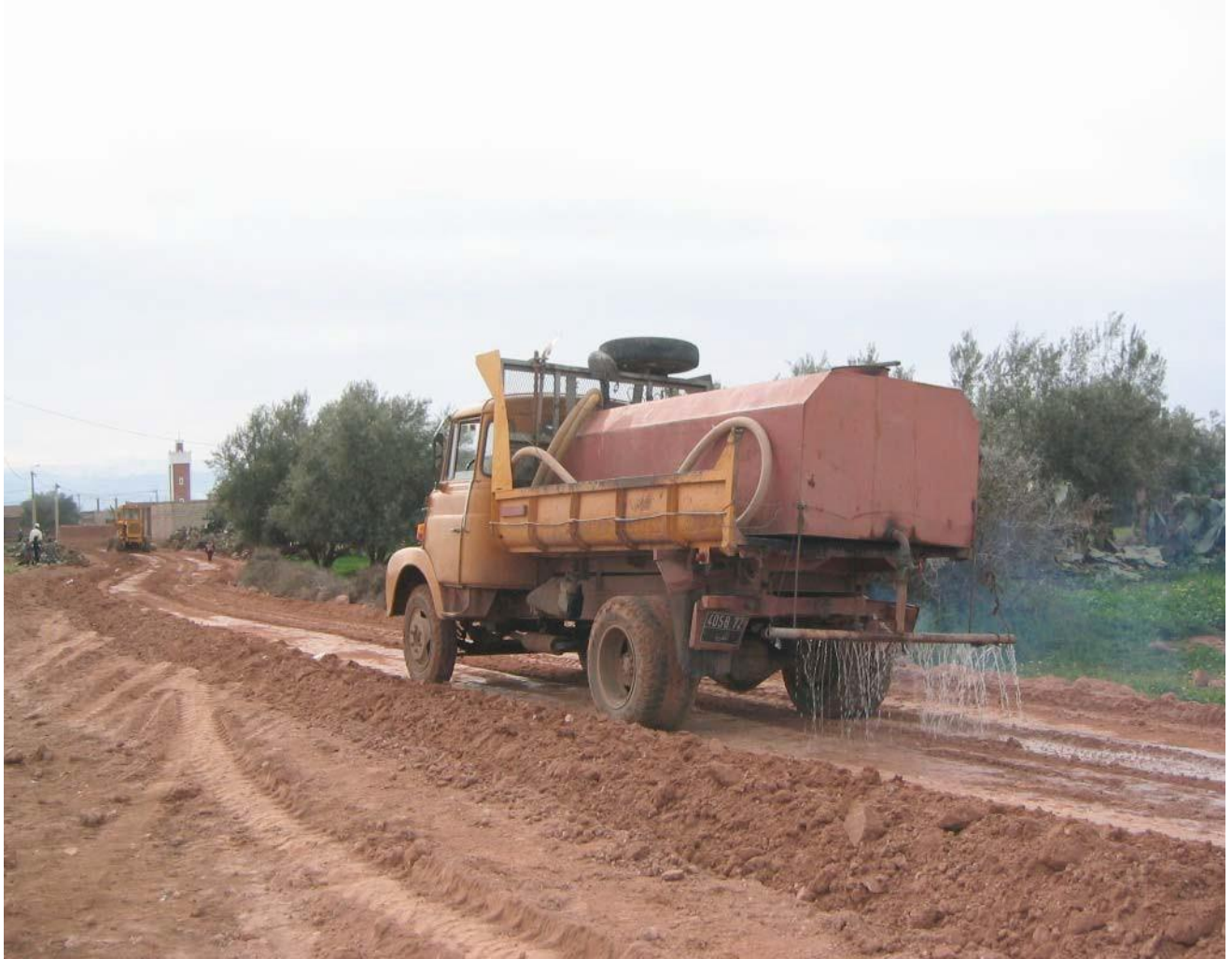
Увлажнение отвала и основания с помощью смеси воды и Escoroads.
