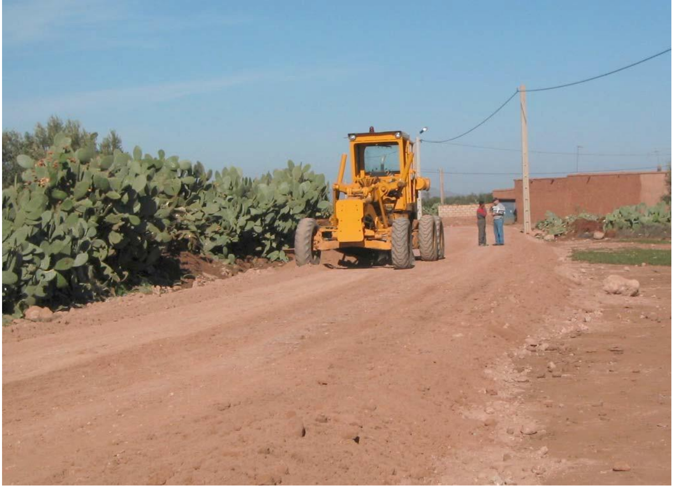
Равномерное разравнивание отвала по дорожной поверхности.
