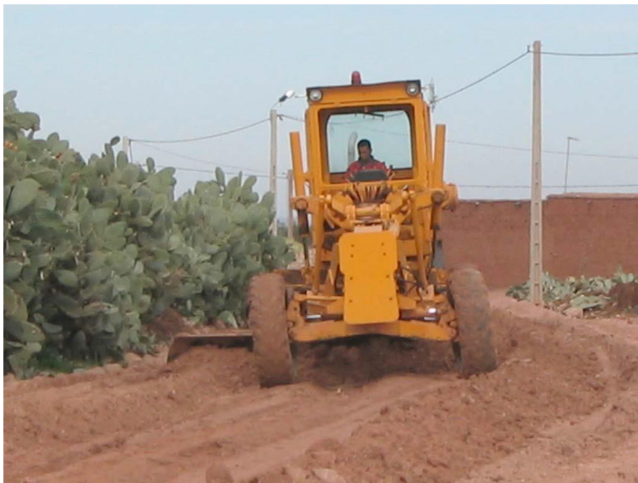
Перемешивание отвала с помощью грейдера.
