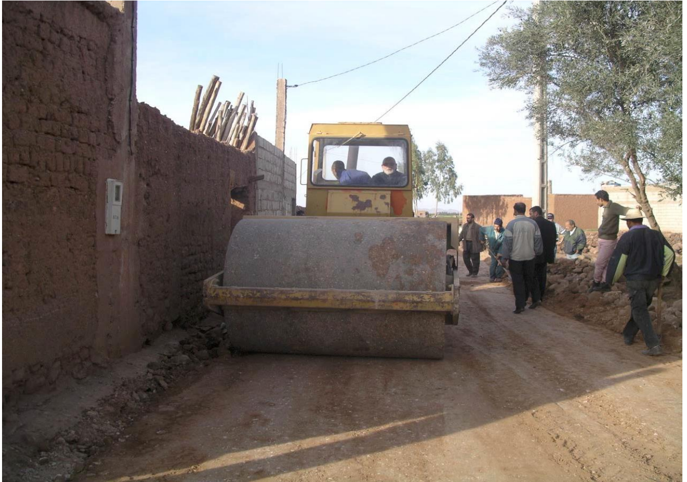
Уплотнение дорожной поверхности с помощью катка (или виброкатка).
